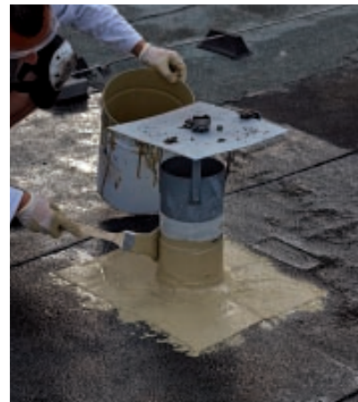
Verarbeitung im Detail: Die passgenauen Vliesstücke werden im KEMPEROL®-Eimer getränkt, aufgebracht und mit dem Pinsel nachgearbeitet.
