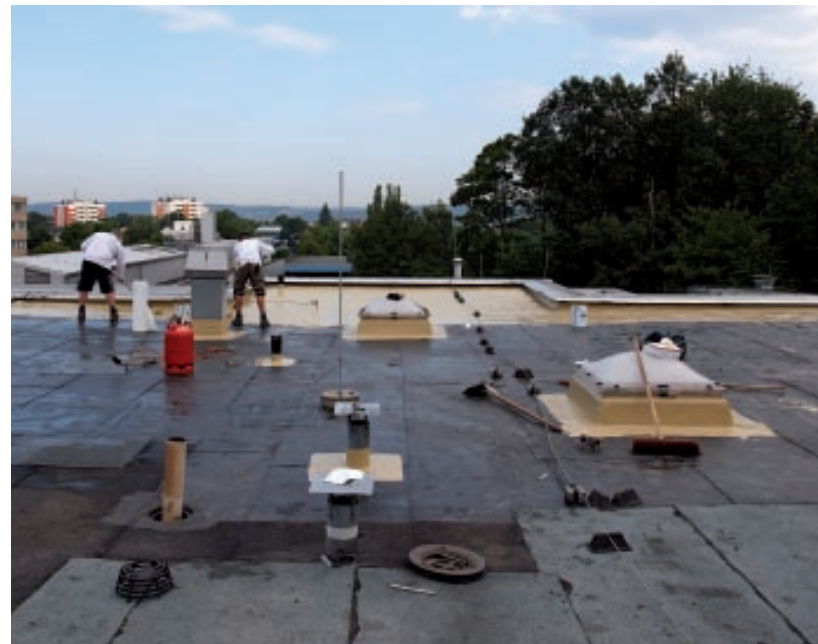
Ansicht der Dachfläche während der Instandsetzungsarbeiten.
