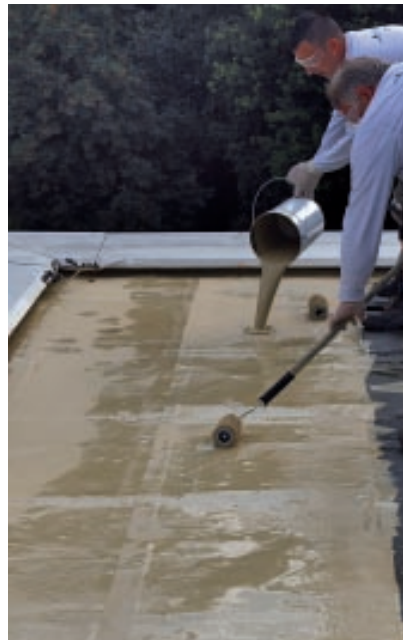
Verarbeitung in der Fläche: KEMPEROL® wird vorgelegt, das Armierungsvlies eingerollt und mit einer zweiten Lage KEMPEROL® nachgearbeitet.
